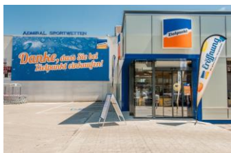
Renovierte Zielpunkt Filiale Wien Rennbahnweg (© Pfeiffer Handelsgruppe)
