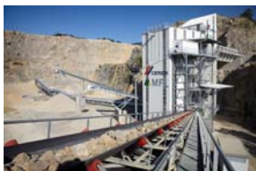
Stationäre Aufbereitungsanlagen von MFL werden passgenau wie ein Maßanzug konstruiert, gefertigt und montiert. (Fotorechte MFL)
